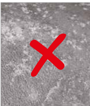
einfache Ausführung: Korrosion
